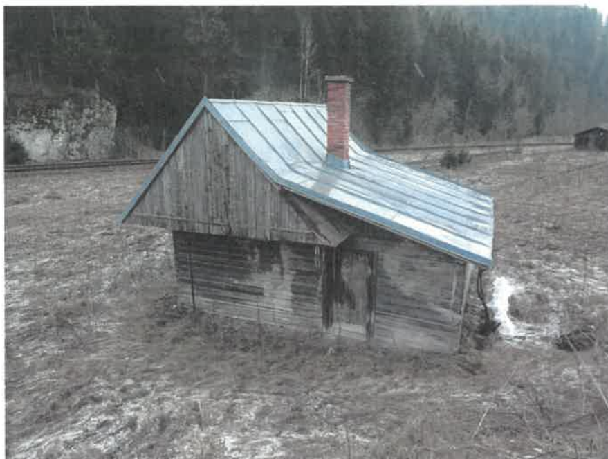
Šatňa č.súp. 789 na parc. č. 4775/18
