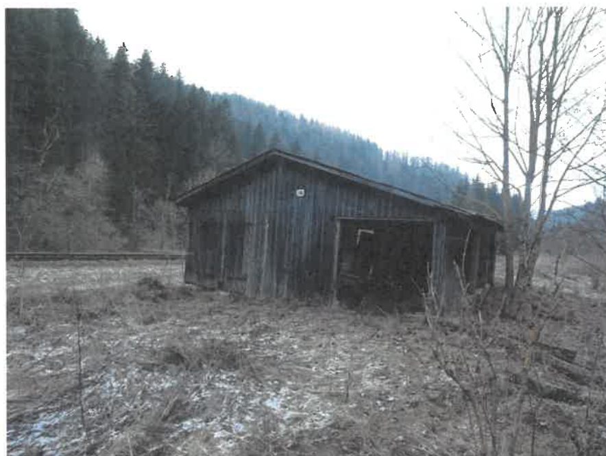
Dielňa č.súp. 700 na parc. č. 4775/17
