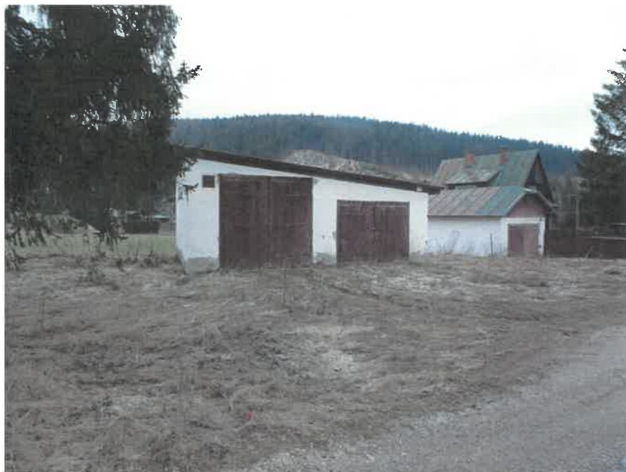
Dvojgaráž č.súp. 749 na parc. č. 4773/6
